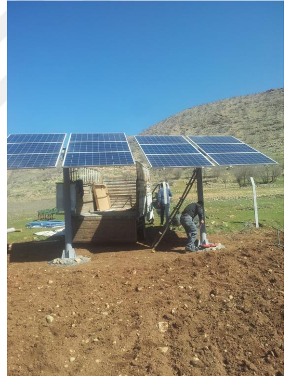
Şekil 5.18 FV panellerin kurulumuna ilişkin fotoğraflar
