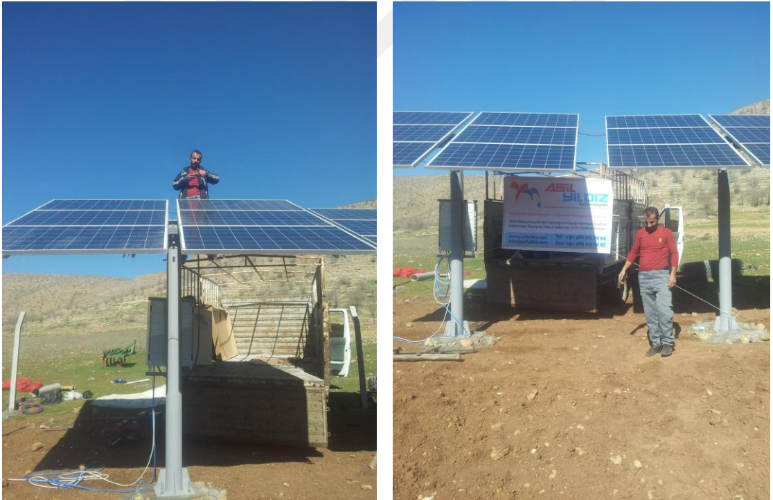
Şekil 5.16 FV panellerin kurulumuna ilişkin fotoğraflar
