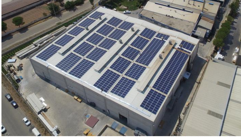
Şekil 3. 2. Güneş panelinin yatay düzleme sabit konumlandırılması
