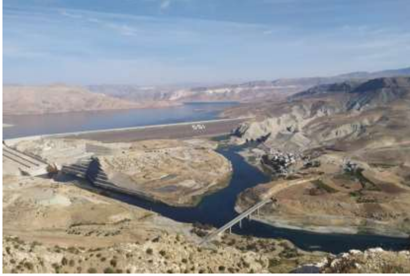
Fotoğraf 2.21. Ilisu Barajı, Ilisu köyü/Dargeçit (K93)
