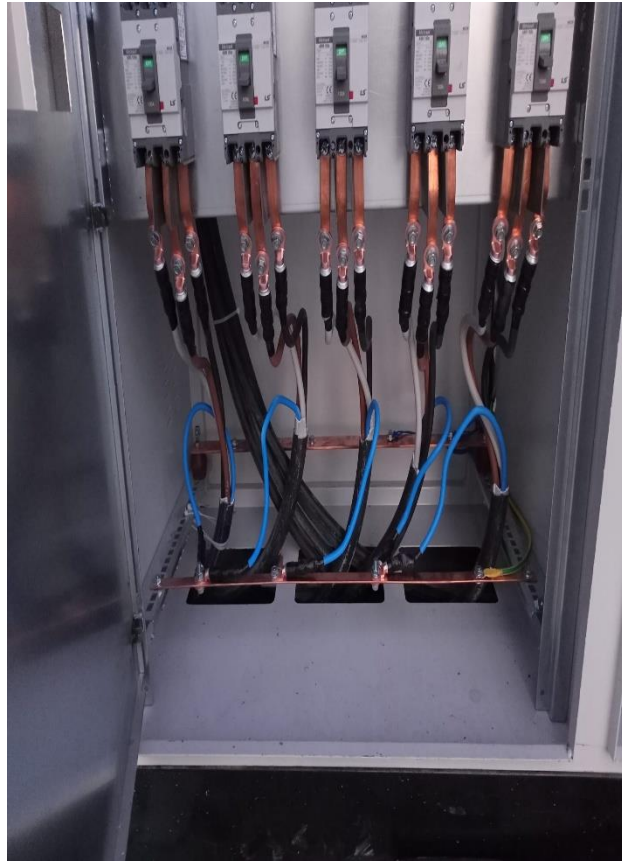
Şekil 5.11. İnverter 'den GES panosuna gelen AC kabloların TMS montajı
