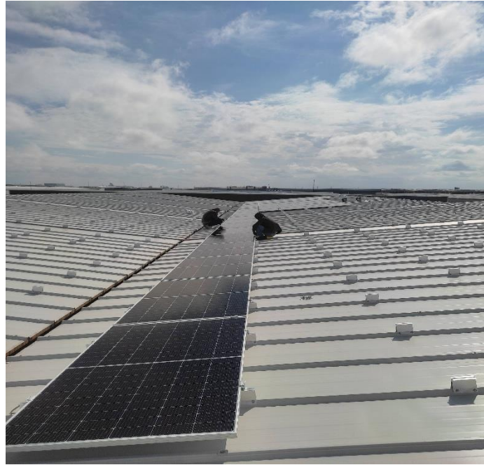
Şekil 5.3. Güneş paneli montajı
