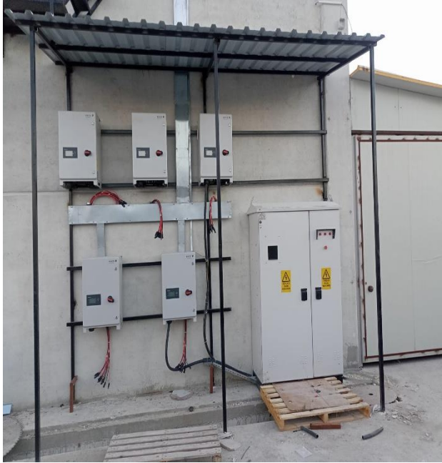
Şekil 5.7. İverter montajı 2
