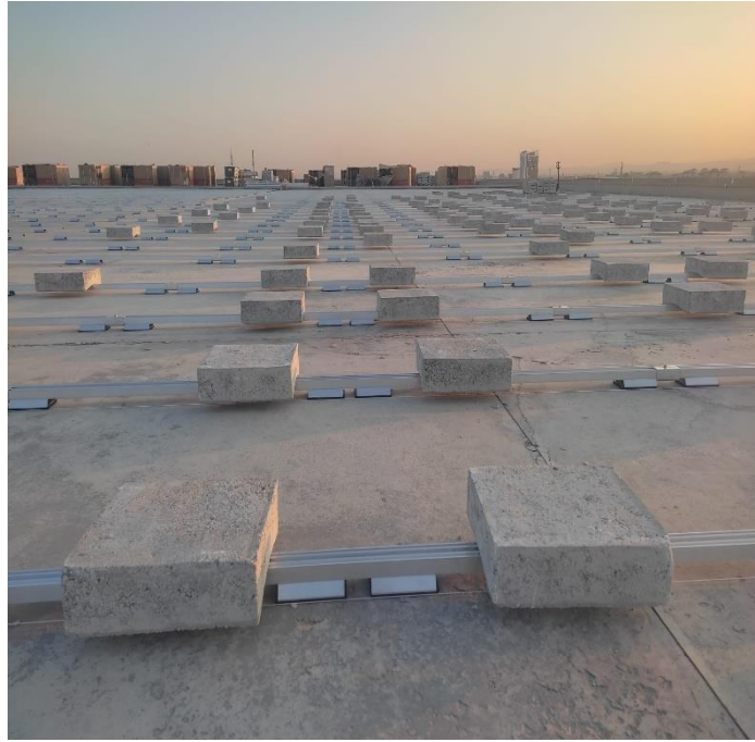
Şekil 5.2. Konstrüksiyon montajı 2
