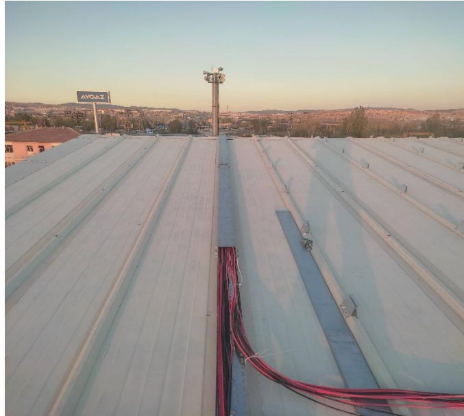
Şekil 5.4. DC kablo montajı
