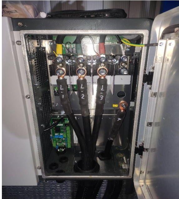
Şekil 5.10. İnverter AC kablo montajı
