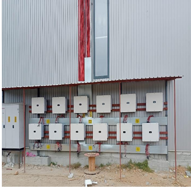
Şekil 5.6. İverter montajı 1
