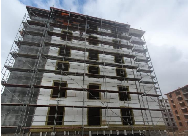
Şekil 1.19. EPS mantolama işlemi
