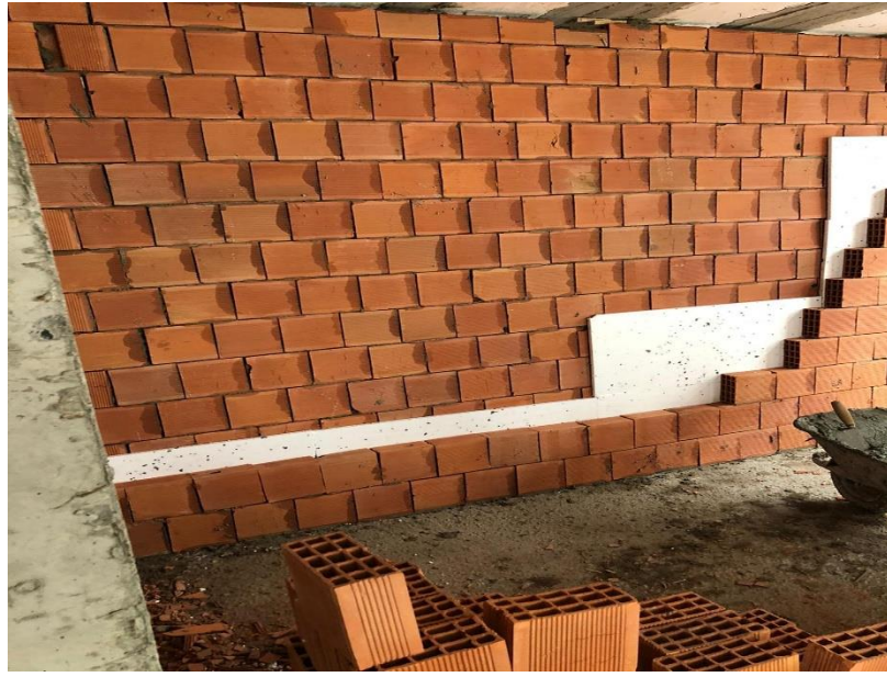
Şekil 1.17. EPS yalıtımlı (Sandviç) tuğla duvar örneği
