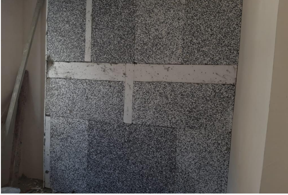
Şekil 1.15. İçten EPS yalıtımlı duvar örneği
