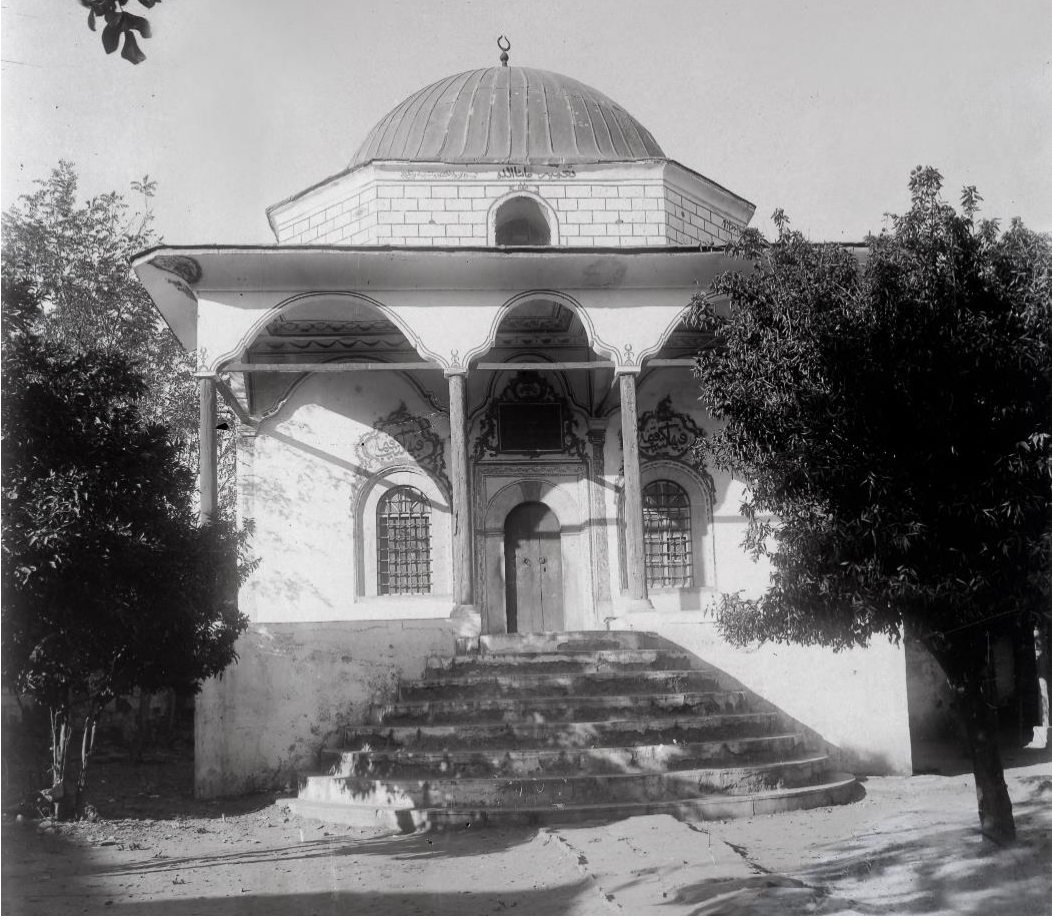
Foto 2.3: Necippaşa Kütüphanesinin Camedânla Kapatılmadan Önceki Hali (M. Topuz Arşivi,1929)
